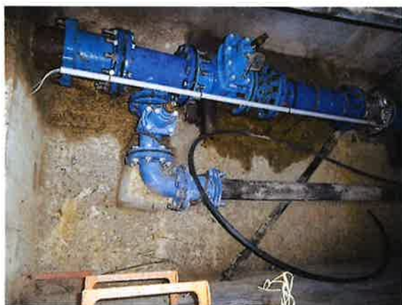
Esquema arqueta de caudalímetro
