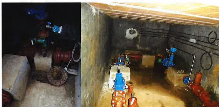
Esquema arqueta reductora de presión
